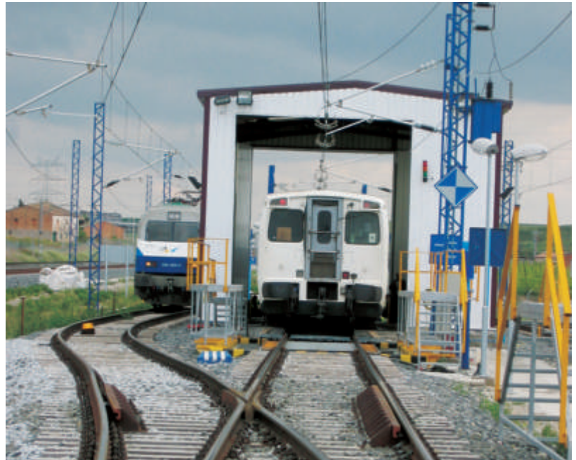
En los primeros cambiadores (como es el de Lérida que aparece en la foto) podía pasar el tren, pero no la máquina que debía reemplazarse en el cambiador. Esto se ha mejorado recientemente y en la actualidad ya pueden pasar máquinas y trenes completos. (Foto: Sergio López Lara).
